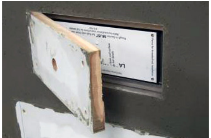
STEP 3 Remove MDF pour support plate.
