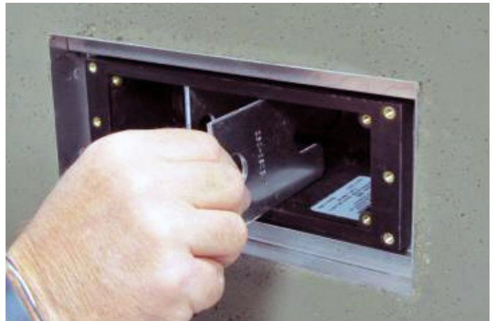
STEP 7 Remove vertical pour support plate.
